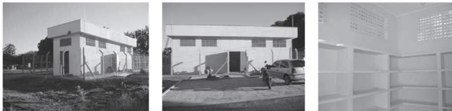
Figura 3 - Fotos do depósito de resíduos químicos perigosos da FCAV-Unesp
