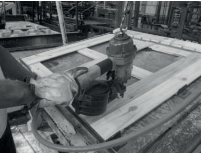
Figura 3: Processo de colocação de balancim
