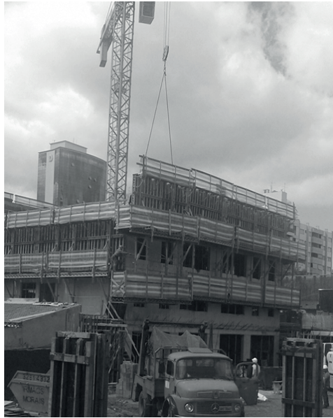
Figura 3: Lançamento da forma com a grua
