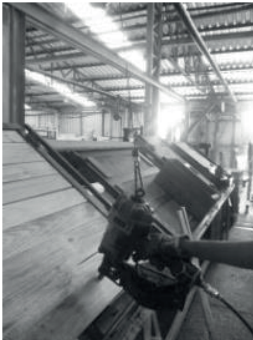
Figura 4: Processo de colocação de balancim
