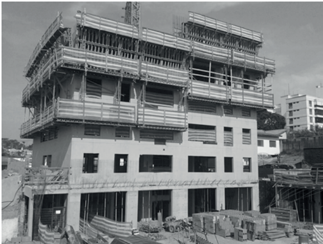
Figura 1: Formas montadas no local com proteções de guarda corpo
